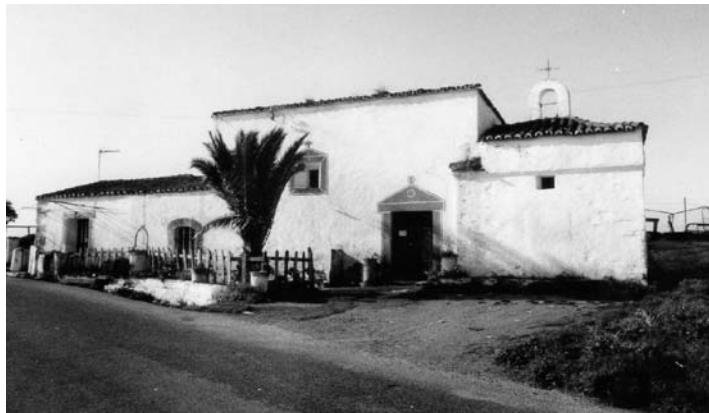
Fig. 1.- Ermita del Amparo antes de su rehabilitación. Archivo Cofradía Amparo.
